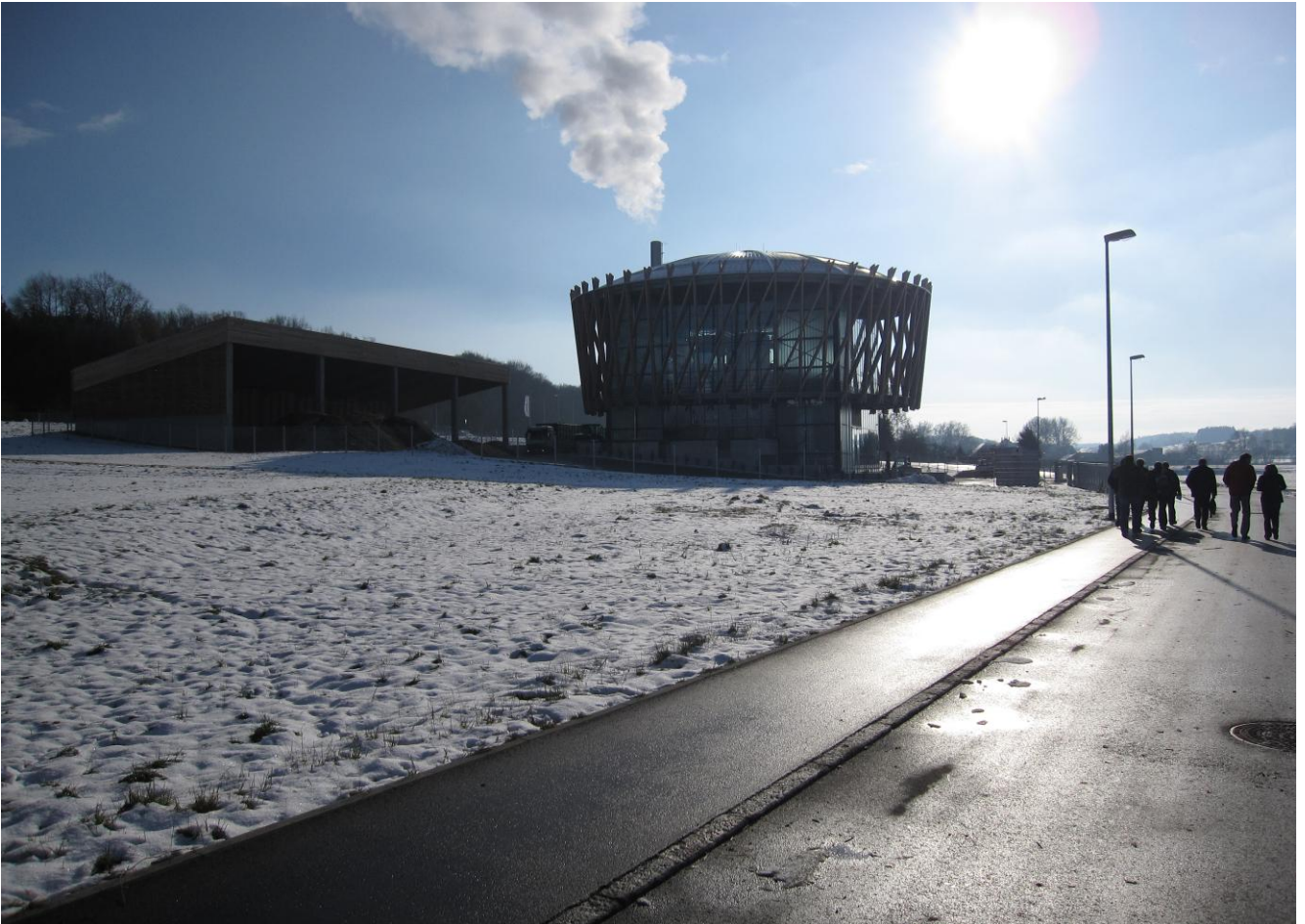
Kuva: Schilling-yhtiön uusi CHP-laitos
